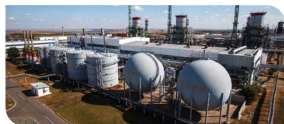
ГЕЛИЕВЫЙ ЗАВОД «ГАЗПРОМ ДОБЫЧА ОРЕНБУРГ» (ВОССТАНОВЛЕНИЕ ПОСЛЕ ТЕХНОЛОГИЧЕСКОЙ АВАРИИ) Введён в эксплуатацию в 2009 г.
