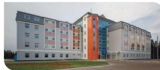
ОКРУЖНОЙ ЦЕНТР ПО ПРОФИЛАКТИКЕ И БОРЬБЕ СО СПИД И ИНФЕКЦИОННЫМИ ЗАБОЛЕВАНИЯМИ В НОЯБРЬСКЕ Введён в эксплуатацию в 2013 г.
